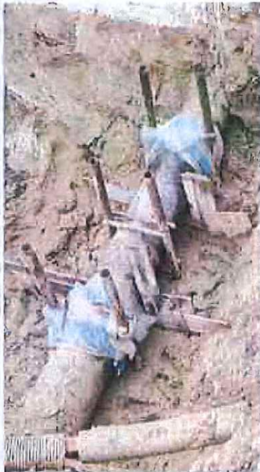
Foto 3: riparazione della condotta DN500
